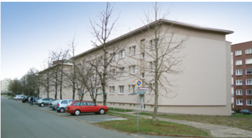
Am Wohnblock Erich-Correns-Ring 1a-2d wurden 2008/2009 die oberen drei Geschosse sowie zwei komplette Eingänge zurückgebaut. Die verbliebenen Wohnungen wurden aufwendig modernisiert.
