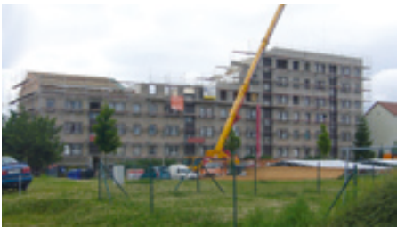
Erstmals in unserer Unternehmensgeschichte wurden 2008 in der Breitscheidstraße Objekte im bewohnten Zustand teilweise rückgebaut und saniert.
