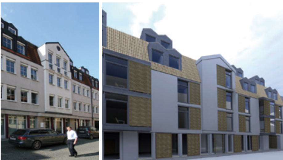
Umbau in der Mangelgasse: Völlig neue Qualität.
