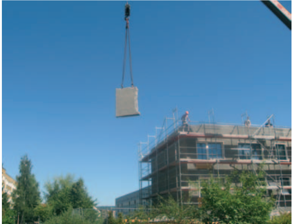
Teilrückbau und aufwendige Sanierung 2008: Johannes-Kepler-Straße 19-25.
