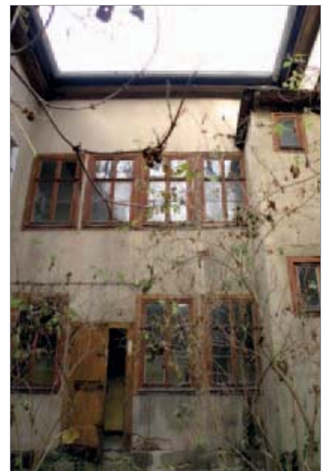
Detail: Die derzeitige Bausubstanz des Palais von der Rückseite.
