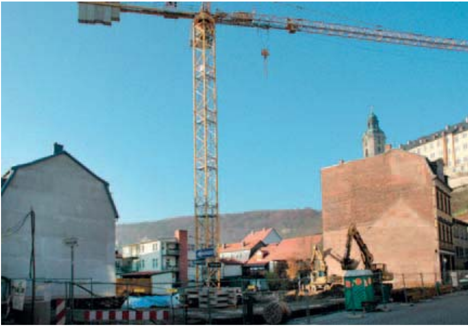
Der Kran steht: Für den RUWO-Neubau in der Mangelgasse.
