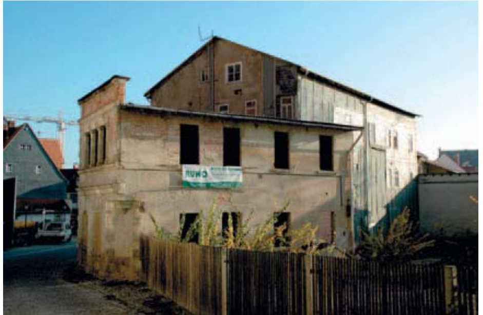
Die RUWO als Bauträger: Für das künftige Wohnen „Am Fürstengraben“.
