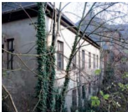
Der Innenhof des Palais.
