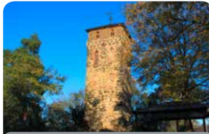
Der Marien-turm wird zurzeit saniert
