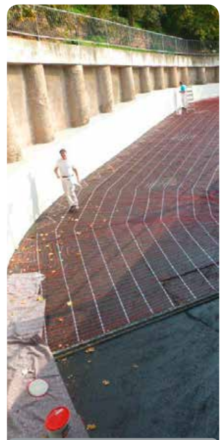
Tüchtige Helfer beim Erneuern der Rampenheizung im Parkhaus Schloßberg
