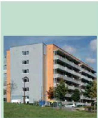
Kopernikusweg 1 nach der Sanierung.
