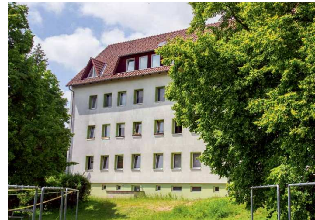
Das parkähnliche Flair hinter den Gebäuden wird auch nach der umfangreichen Baumaßnahme erhalten bleiben. Dann werden die Bewohner einen schönen Blick von ihren neuen Balkonen genießen können.
